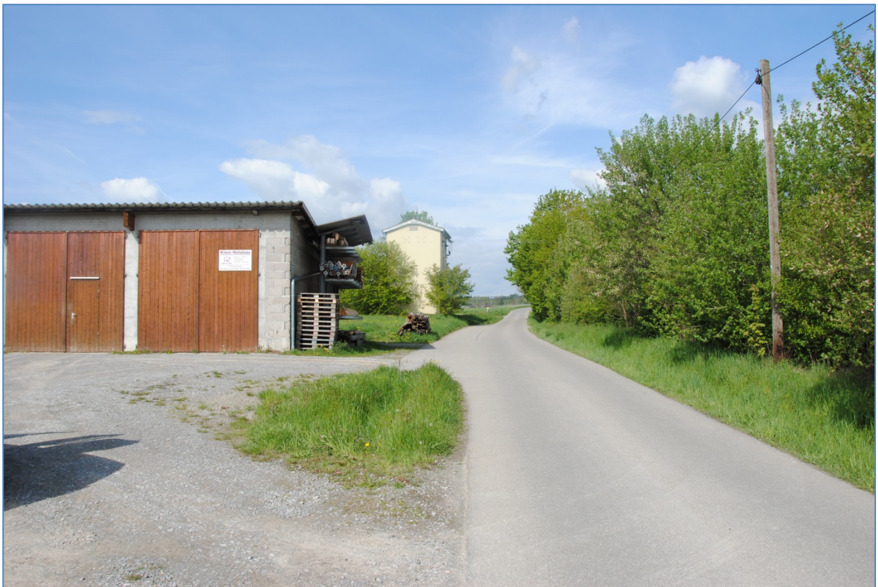
Abbildung 4.2 Schotterplatz, Scheune und Trafohäuschen am Grubstockweg (Mai 2019)
