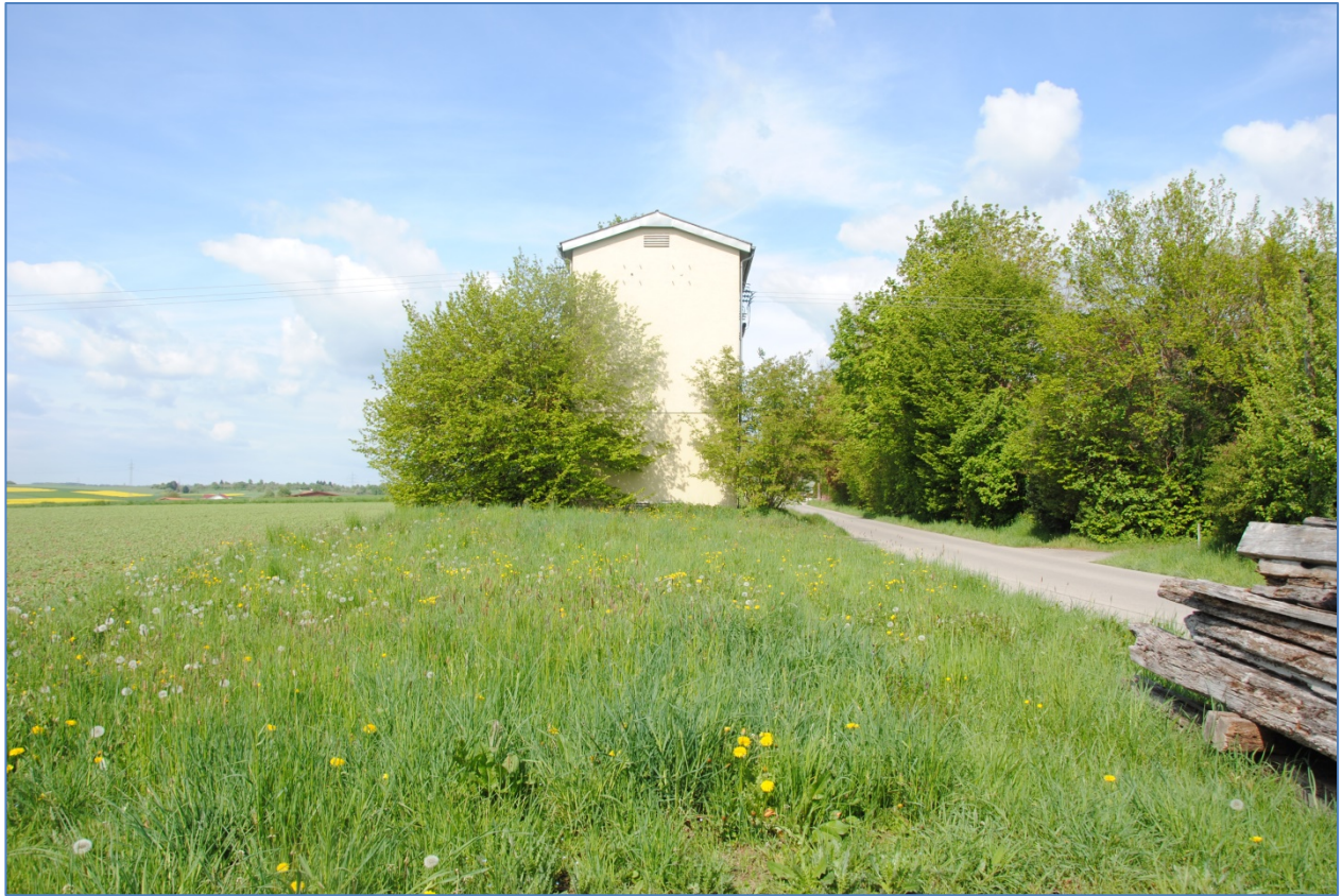
Abbildung 4.3 Fettwiese und Gehölz am Trafohäuschen (Mai 2019)
