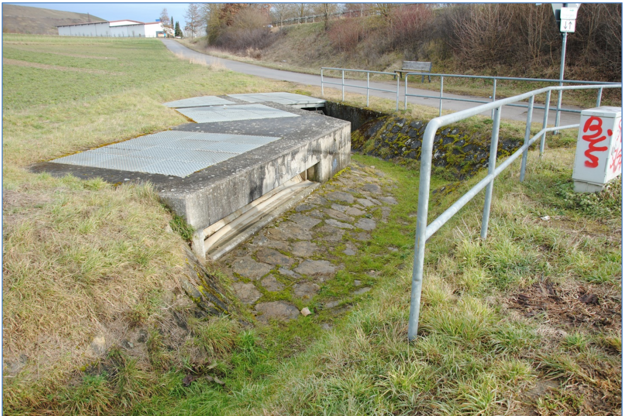
Abbildung 4.6 Teilbefestigter Graben und Schachtbauwerk im Süden (Januar 2020), im Hintergrund: Straßenböschung der Nordwestlichen Randstraße K1002
