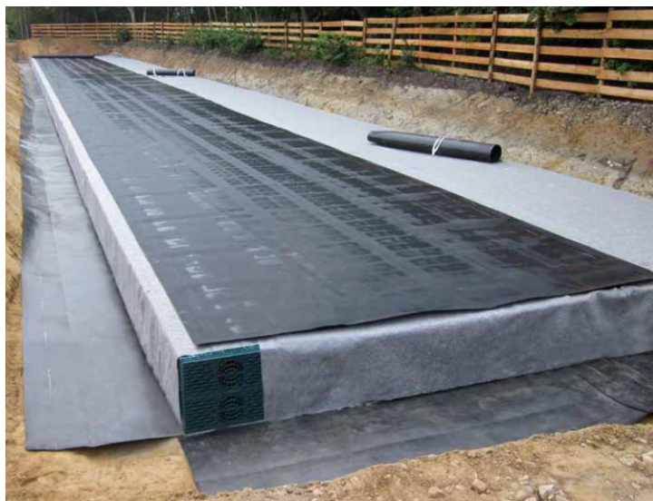
Abbildung 7: Unterirdische Zisterne zur RW-Nutzung (Beispiel RigoCollect, Fränkische)
