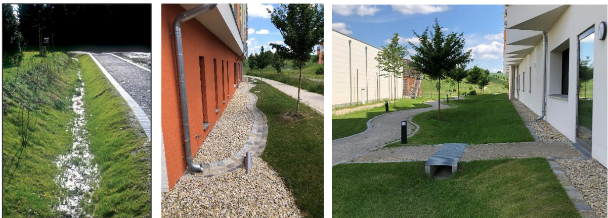
Abbildung 4: Oberflächennahe Sammlung und Ableitung, Quelle: Solingen Börkhauser Feld (links) und EQP Pfaffenhofen (mitte/rechts)
