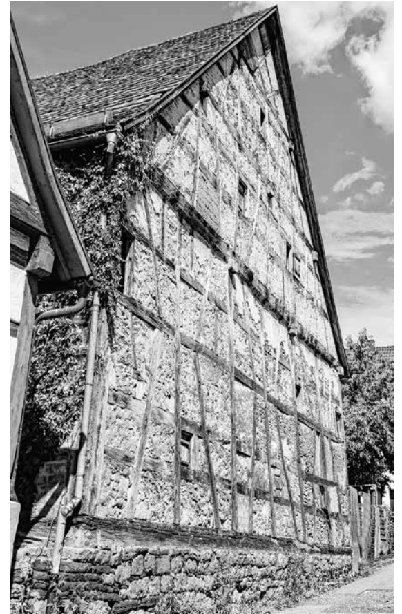
Denkmalgeschützte Scheune Burgstraße 35
