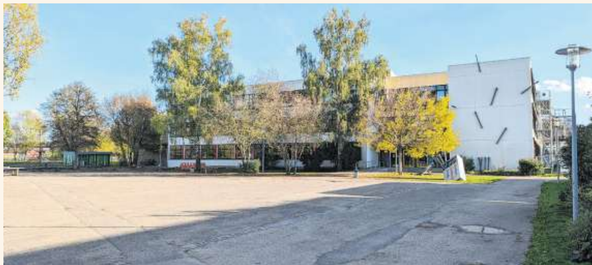
Auf dem bisherigen Schulhof der FKG soll ein Neubau für eine Grundschule errichtet werden. Foto: Gemeinde
