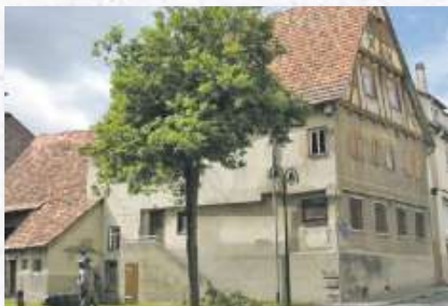
Das „alte Pfarrhaus“ vor der Sanierung. Links die inzwischen abgerissene Scheune. (Foto: Horst Kremer)
