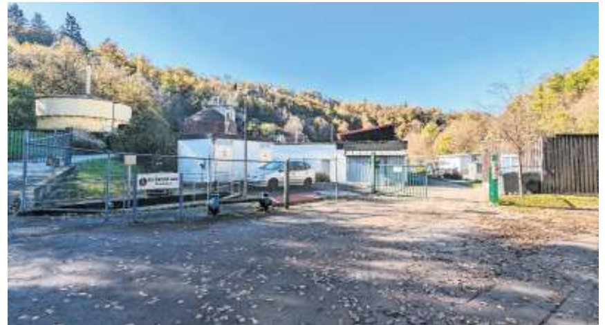
Die Kläranlage in Ehningen. Foto: Gemeinde
