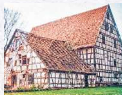
Doppelscheune Südseite mit Göpelhaus vor dem Abbruch um 1988
