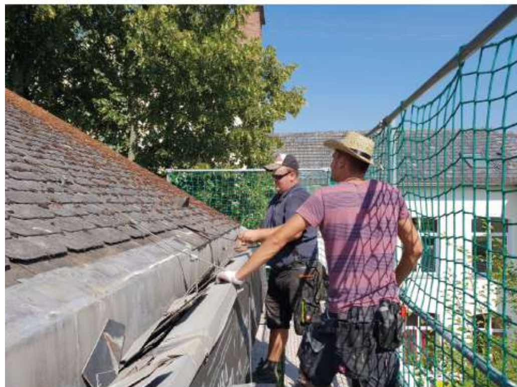
Verklammerung und Befestigung der Dachziegel bzw. -platten werden beim DachCheck geprüft.
