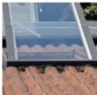
Anschlüsse an Dachdurchdringungen bei Dachfenstern werden beim DachCheck begutachtet. Foto: HF Redaktion/akz-o
