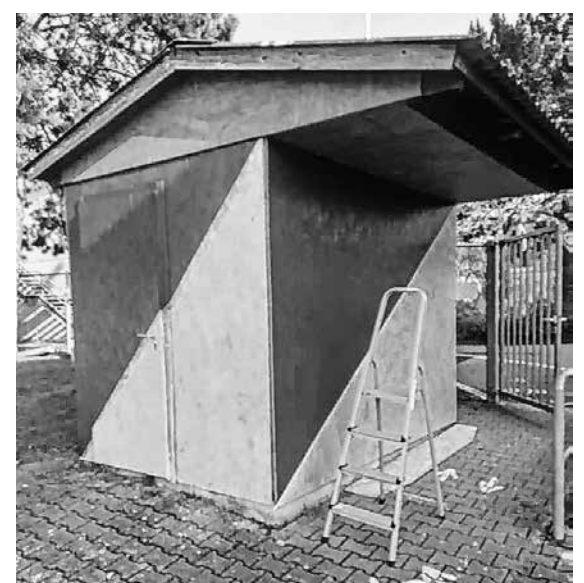
Das Kassen- und Strehhäuschen in stahlendem Blau-Gelb
