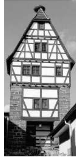
Storchenturm – Beginn des Wehrgangs – Bild privat
