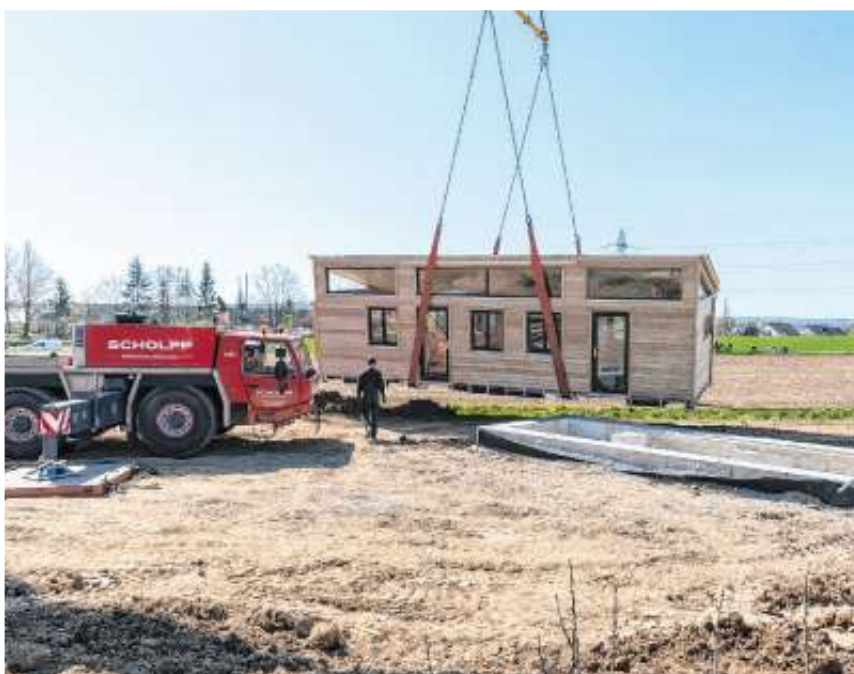
Auch Häuser müssen manchmal fliegen
