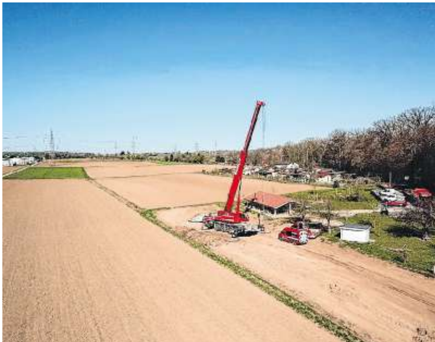
Der Schwerlastkran bringt sich in Position
