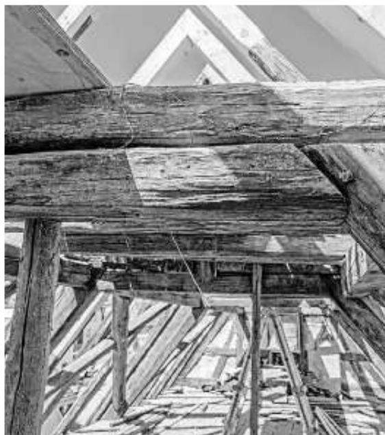
Alte und neue Hölzer wurden von den Zimmerleuten fachmännisch und dauerhaft miteinander verbunden
