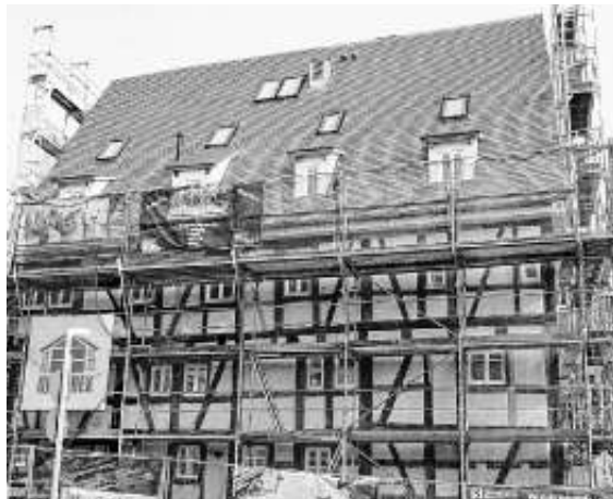
Einladend steht das Gebäude im neuen Glanz – noch mit Gerüst und Schutznetzen
