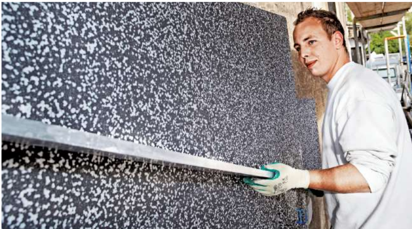
Eine gedämmte Gebäudehülle senkt erheblich die Stromkosten beim Betrieb von Wärmepumpen.
