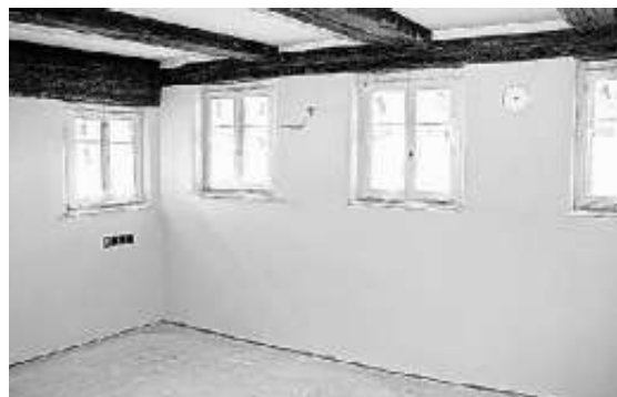
Die Innenräume sind unter Erhalt der historischen Bauelemente zeitgemäß ausgestattet (Fotos: Hans-Werner Heidbrink)
