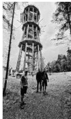
Der zu bezwingende Turm
