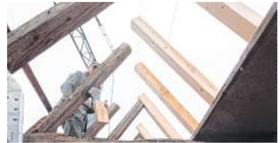
Das Dach wird neu aufgebaut
